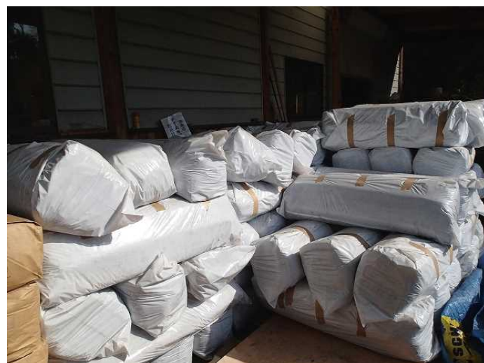
植生基材を円筒の袋に封入（植生基材封入袋）
