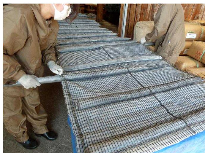
植生基材を円筒の袋に封入（植生基材封入袋）
