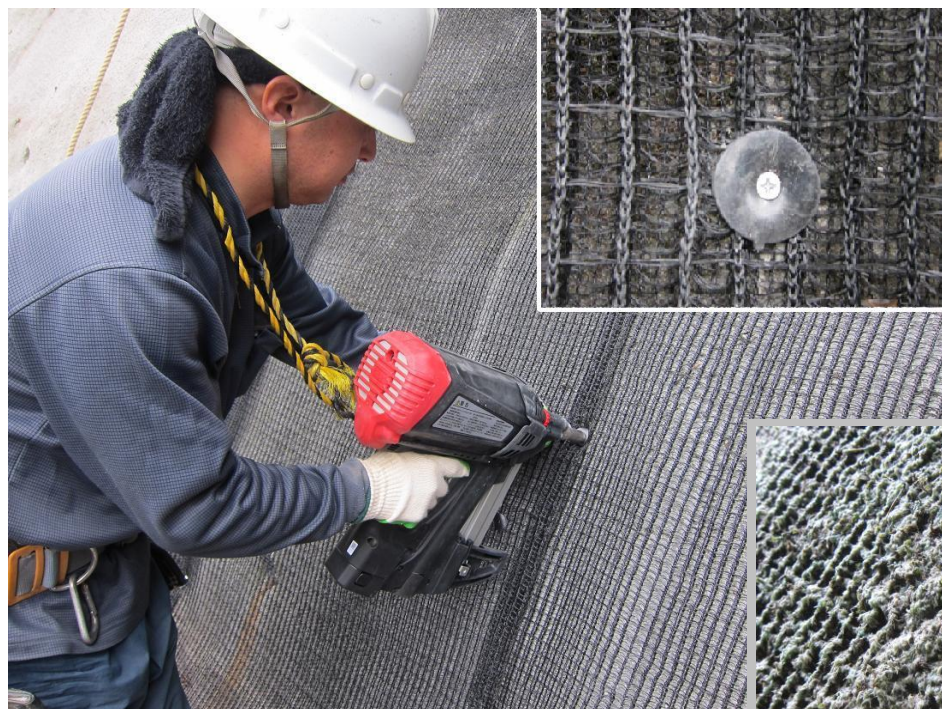
植生立体ネット張工
