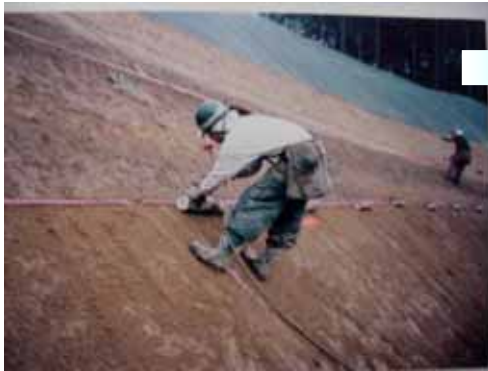
丸太植栽工 布設、アンカーピン打込
