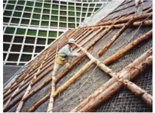
丸太法枠工 枠組立、アンカーピン打込
