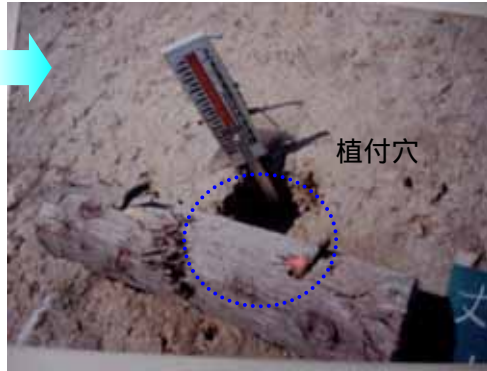
丸太植栽工 L=0.6m/個 丸太筋の上部へ植穴
